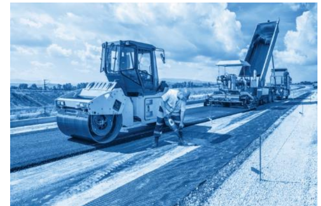
Строительство и ремонт
