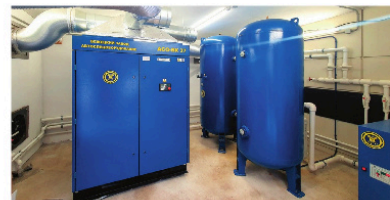
Винтовой компрессор АСО-ВК37 и ресиверы РВ900 на ООО «СТАЛЬ-ГРУПП»
